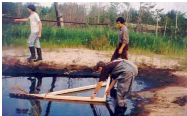
1 Очистка водоема от нефти препаратом «Родер» (Урай, 1996 г). а) Сначала нефть лучше собрать механически. б) А потом обработать препаратом «Родер».
